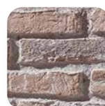
Arcilloso Caleado Ref. 76
